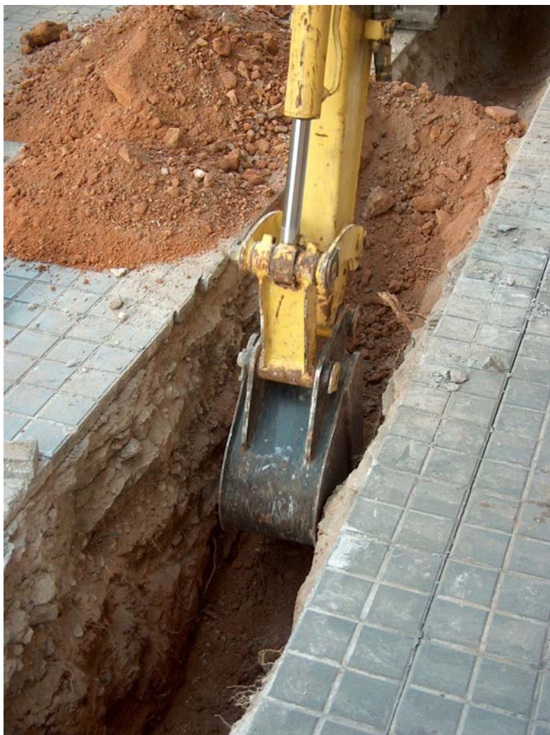
Foto 1: Obertura de la rasa a màquina.
